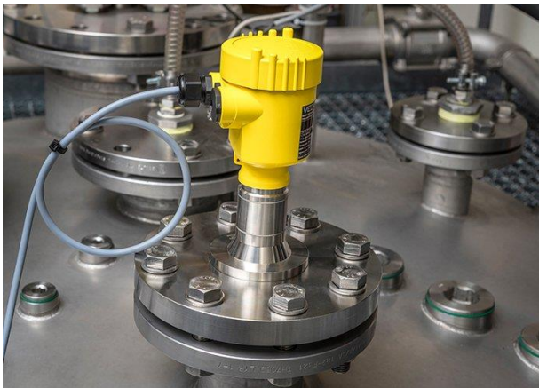
Capteur de niveau radar fixé par bride (Image VEGA)
